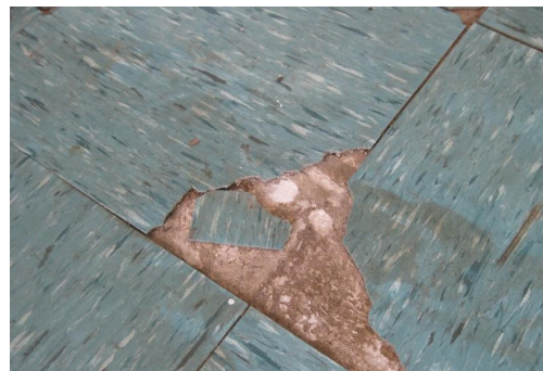
Dalle de revêtement de sol
